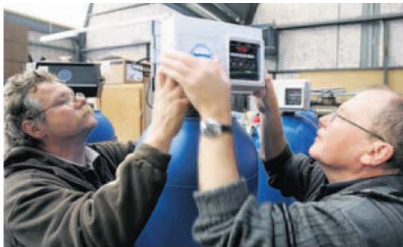
Fritz Sturzenegger (links) und Hans Peter Ritz bei der Montage
